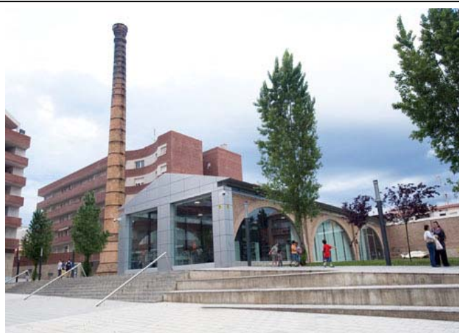
Exterior de la Biblioteca de Torredembarra. Foto: arxiu sr. Huguet.
